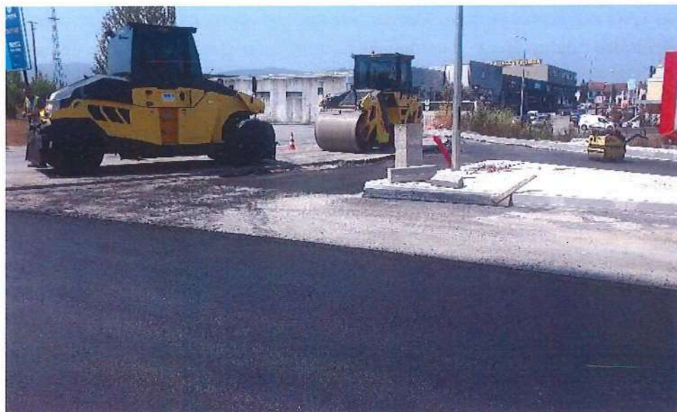
Fig. 14 – Pavimentação da integração dos trabalhos da variante na rotunda existente
