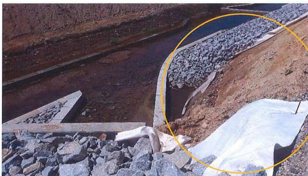
Fig. 11 – revestimento dos taludes a executar PH3.1
